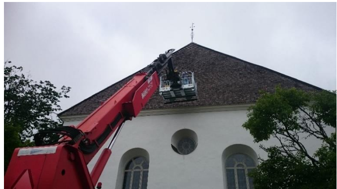
Figur 18. Den mobila arbetsplattformen vid körning av plattform.
