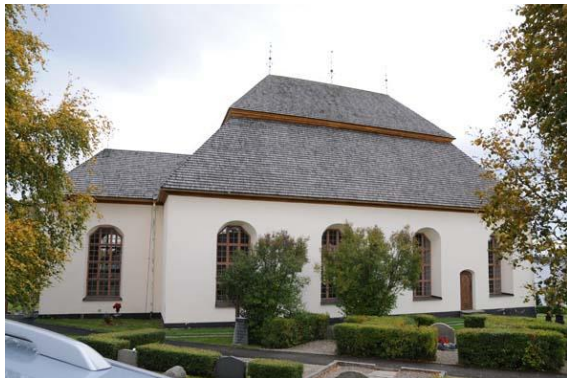
Bild 3. Hallens kyrka spåntäckning med kyrkspån
