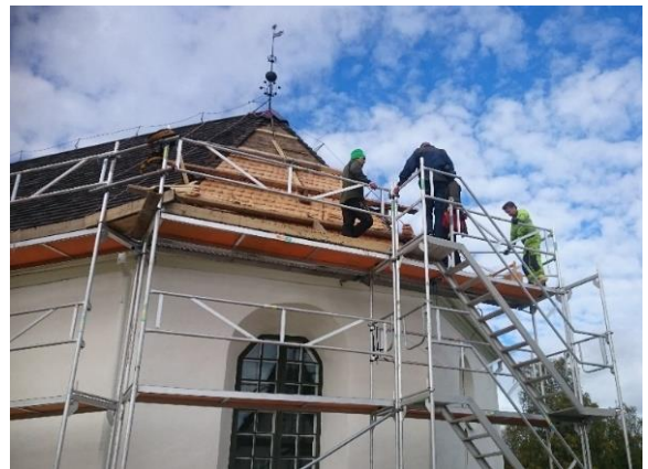
Bild 6 a och b. Byggnadsställning vid mer omfattande omläggning av kyrkspån. Mattmars kyrka, Jämtland. a) Långsidan. Obs. felaktigt skyddsräcke, ska vara klass C (tätare och högre bärförmåga). b) Tillträde till ställning och tak.
