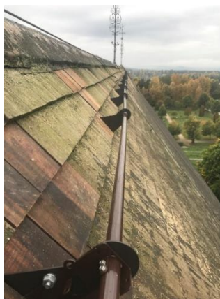
Figur 1. (t.v) Arbete på kyrktak med kyrkspån med hjälp av utvecklad Taksäkerhetsprodukter
