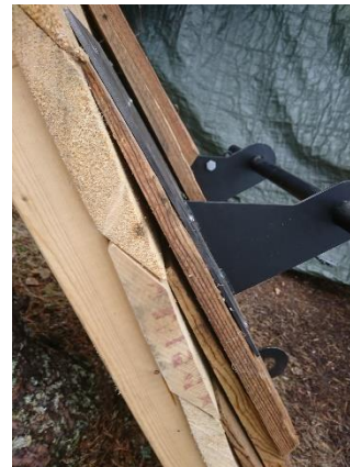
Figur 37. Befintlig taksäkerhet på huvudbyggnadens tak Ljusdals kyrka, i form av förankringsögla och infästning av takstegen. Båda ser ut att vara skruvade med så kallad Fransk träskruv.
