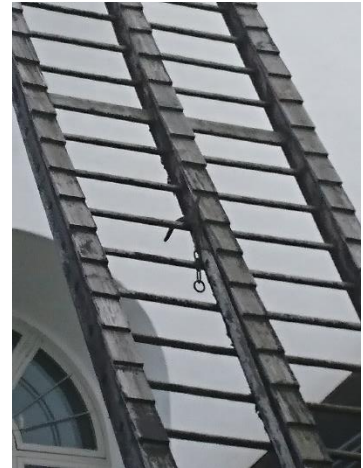
Figur 31. a Takstege på Torsåkers kyrka (Ångermanland) b. Stege från mark tillnock Ljusdals kyrka.
