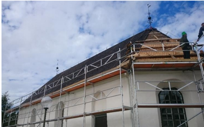
Bild 6 a och b. Byggnadsställning vid mer omfattande omläggning av kyrkspån. Mattmars kyrka, Jämtland. a) Långsidan. Obs. felaktigt skyddsräcke, ska vara klass C (tätare och högre bärförmåga). b) Tillträde till ställning och tak.
