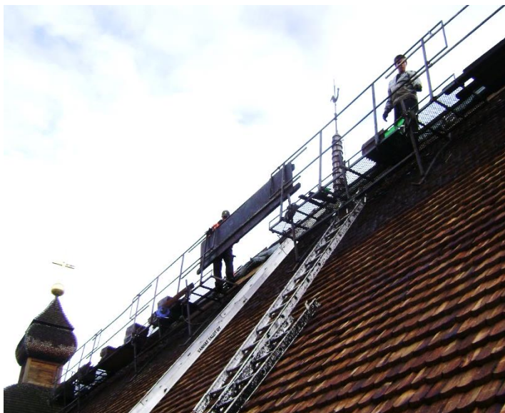
Bild 29. Exempel på takplacerad mobil arbetsplattform vid byte av kyrkspån på Torsåkers kyrka, Ångermanland 2006. Förflyttning upp/ner med handvinsch. Materialtransport med snedbanelyft.
