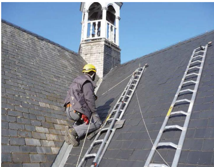
Bild 25 a, b. Upphängning av lös takstege i krok enligt traditionell tysk arbetsmetod.
