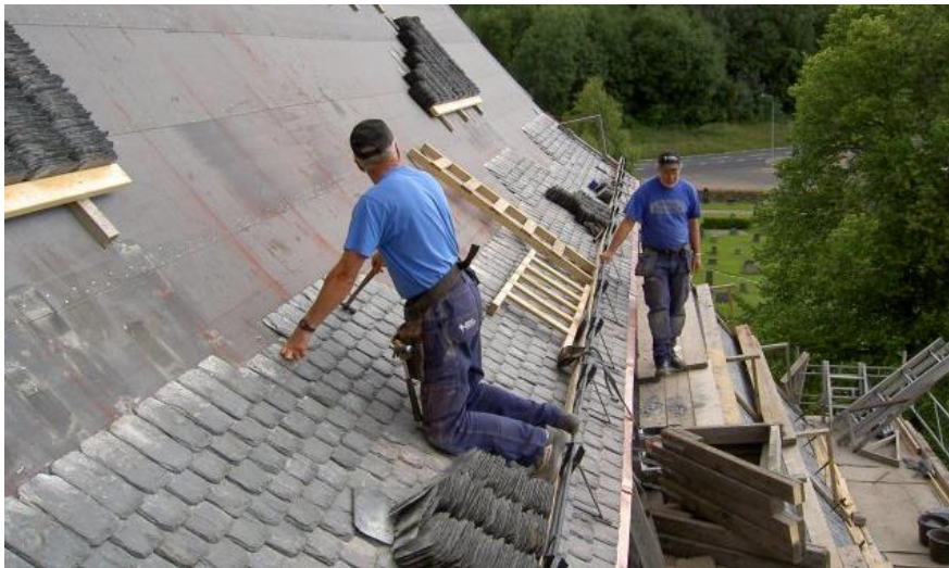
Bild 28. Skifferläggning med metod som med dagens arbetsmiljöregler inte är tillfredsställande. Personlig fallskyddsutrustning eller arbetsplattform med skyddsräcken. Även säker tillträdesled och räddningsmetod måste ses över.
