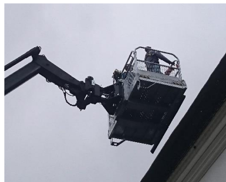
Figur 20. Plattformen nära takkant. Här syns balken som måste tryckas mot takyta för att kunna öppna grindarna.
