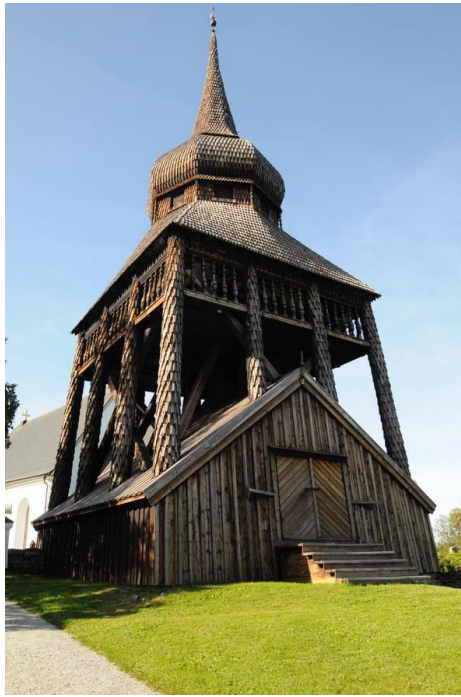
Bild 9. Frösö klockstapel med spåntäckning av kyrkspån och brädtak på klockbod.
