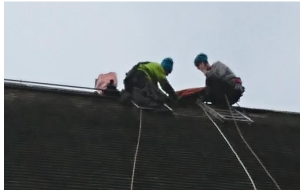
Figur 39. Montering av nockräcke med hjälp av hängande stegar och PFU.
