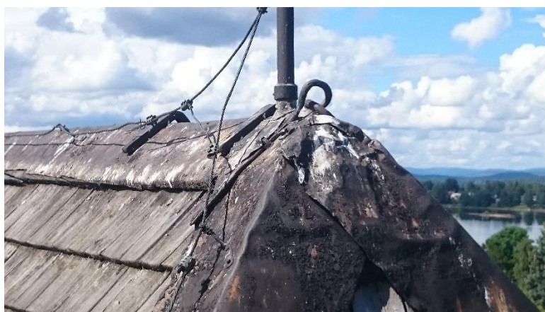
Figur 37. Befintlig taksäkerhet på huvudbyggnadens tak Ljusdals kyrka, i form av förankringsögla och infästning av takstegen. Båda ser ut att vara skruvade med så kallad Fransk träskruv.
