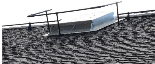
Figur 32. Tillträdeslucka, med räcke, på skiffertak.
