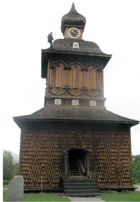
Bild 10. Klockstapel i Anundjö med spåntäckning. Med kyrkspån. Observera att reparationer pågår!
