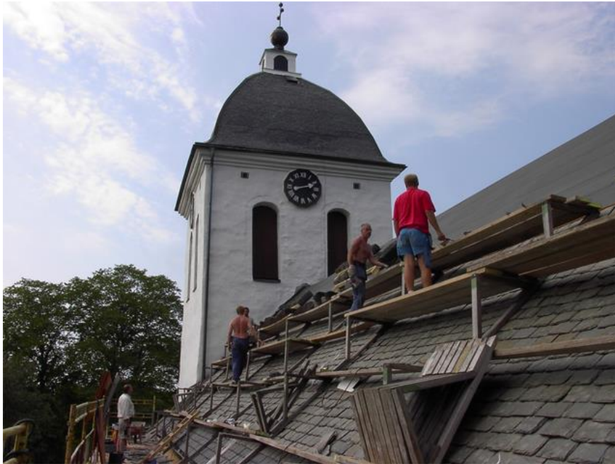
Bild 27. Arbetsplattformar vid skifferläggning på kyrktak. Måste kompletteras med godkända skyddsräcken vid takfot och på de arbetsplan som brukas och/eller personlig fallskyddsutrustning.
