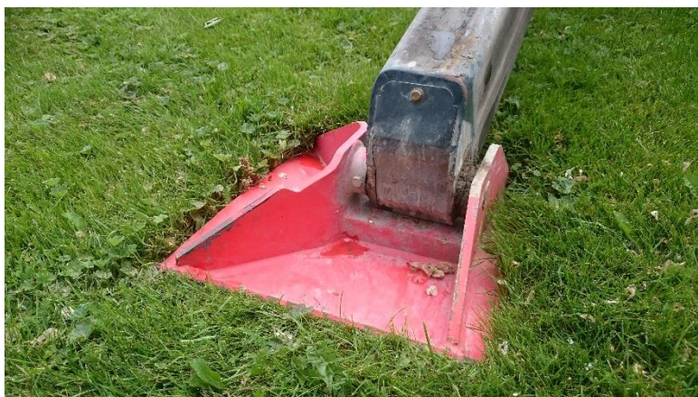
Figur 23. Stödbenet till den mobila arbetsplattformen tränger ner i underlaget. Marktrycket stort. Ofta låg bärförmåga på kyrkogårdar.
